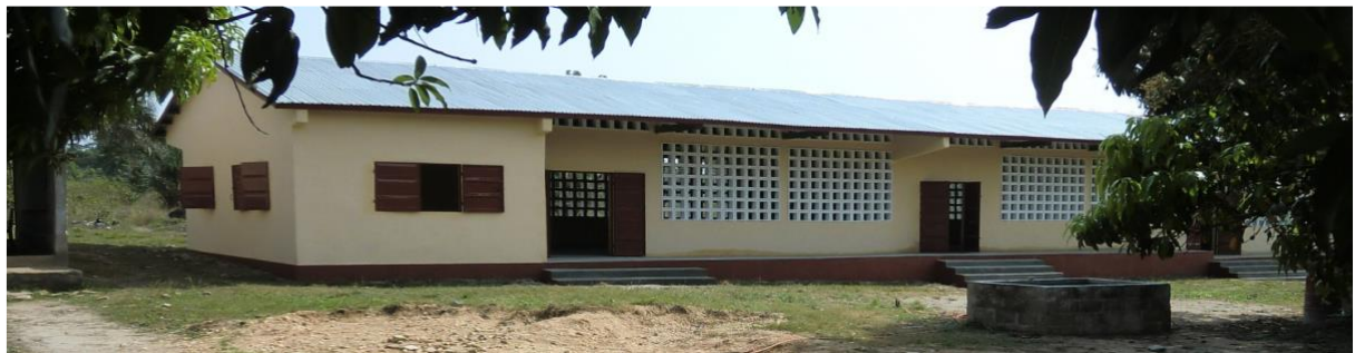
Neues Schulgebäude mit abschließbaren Türen und Fenstern
